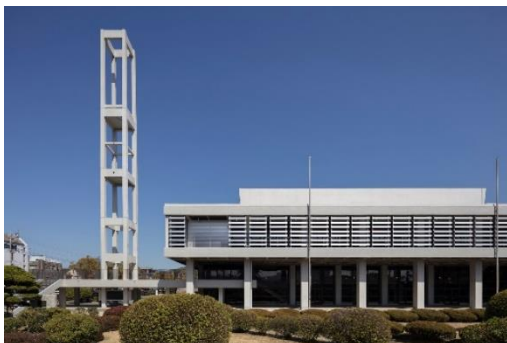
防府市公会堂 —山口県防府市—
