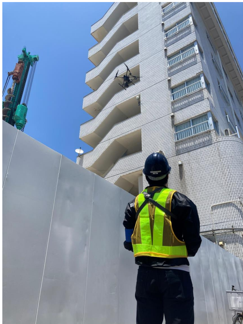
外壁調査の様子
