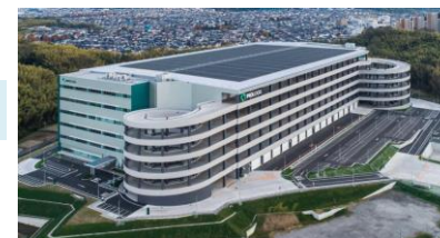
京都府京田辺市 物流倉庫
