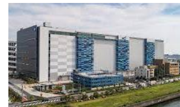
千葉県船橋市 物流倉庫
